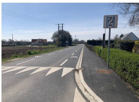
Signalisation Rue de l'Aérodrome RD 191E1
