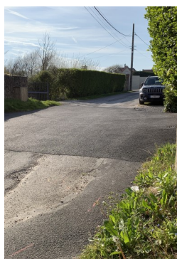
Chaussée drainante Rue Romaine
