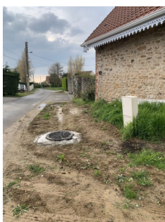
Busage et fossé Rue des Haguettes
