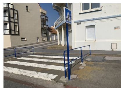
Remise en peinture des barrières de sécurité des passages piétons
