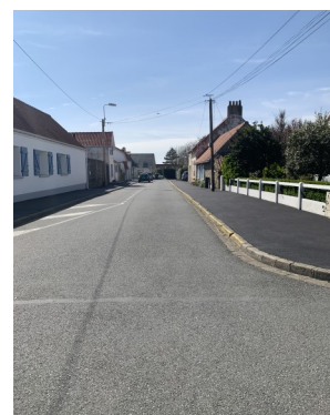
Réfection des trottoirs Rue du Presbytère
