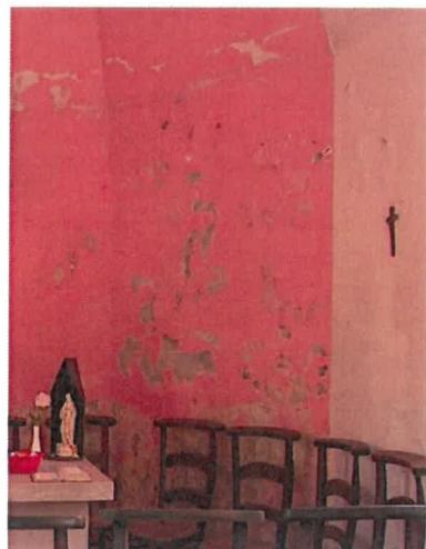
Des problématiques conjointes d'humidité et d'étanchéification des murs (matériaux inadaptés type ciment et enduits non respirants) ont induit une remontée de l'humidité dans les murs, qui fait aujourd'hui cloquer l'enduit intérieur et apparaître du salpêtre.
